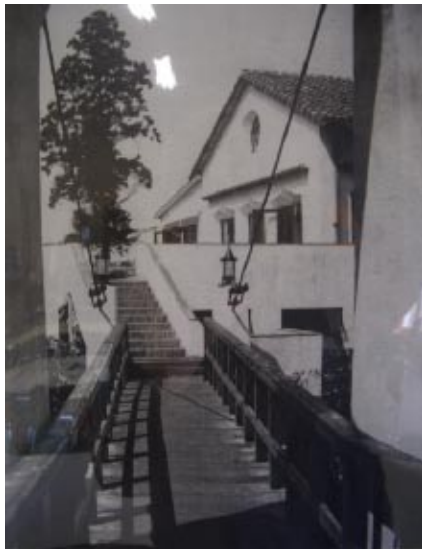
吊り橋から二階テラスを見る（吊り橋は現存せず）
